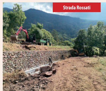
Loc Battistoni: ultimati lavori di somma urgenza di ricostruzione versante e viabilità
