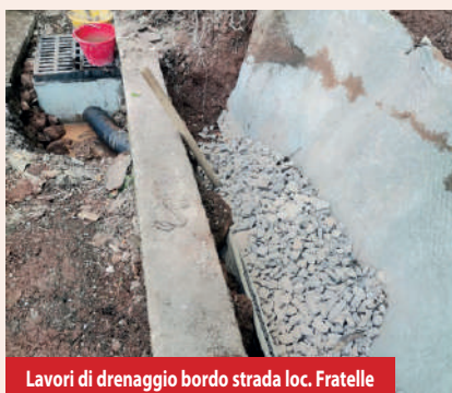
Lavori di manutenzione strada Costarefolo-Cavecchia, posa tubazioni acqua potabile, rete nyobcendio e cavidotti corrente elettrica, drenaggi e tubazioni di scolo
