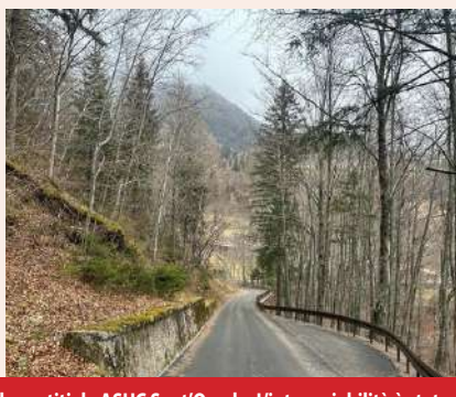
Strada delle Fratelle. Lavori di asfaltatura finale gestiti da ASUC Sant'Orsola. L'intera viabilità è stata sistemata negli anni a piccoli step esecutivi con i primi appalti dal Comune per la parte di protezione dei versanti e barriere stradali con prime asfaltature, dal Consorzio di Miglioramento Fondiario con l'allargamento dell'incrocio per la località Facchini. Sinergia attiva tra enti: un esempio importante
