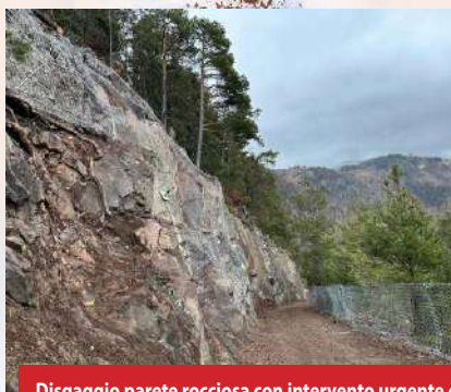
Disgaggio parete rocciosa con intervento urgente chiodatura parete e protezione verticale di contenimento sulla strada Sas Scorz sopra l'abitato della frazione Conti
