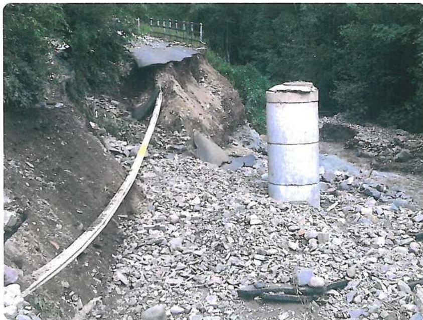
Strada ciclo-pedonale sul Fersina a monte loc. Caspito
