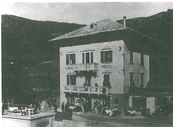
L'ex albergo Posta ed i campi di bocce
