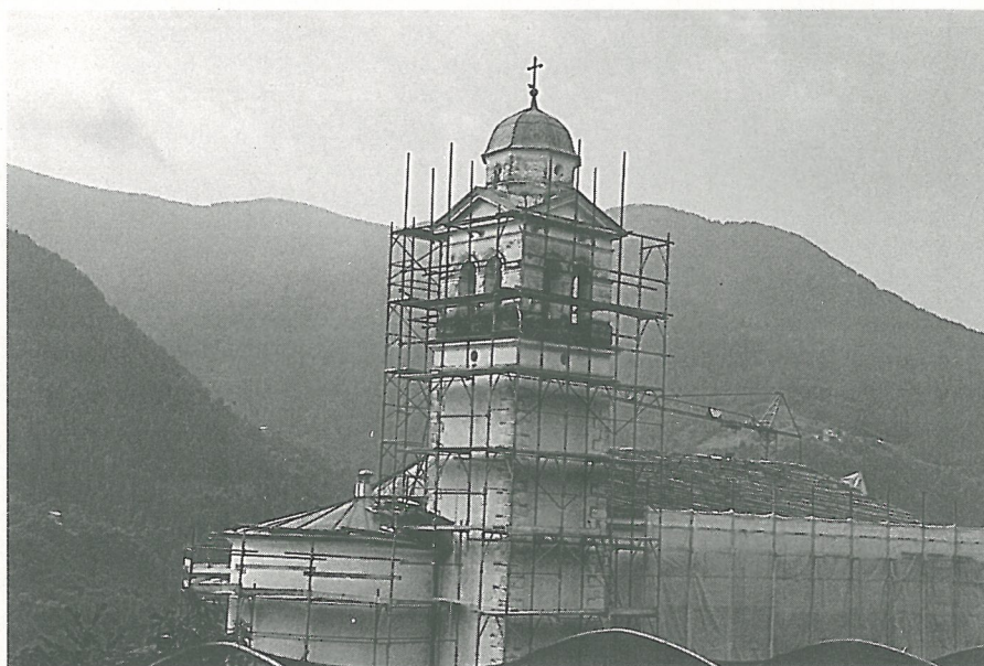
Si vedono in fotografia, lungo il perimetro esterno della chiesa, i pontigli che si elevano fino a imprigionare la sommità del campanile
