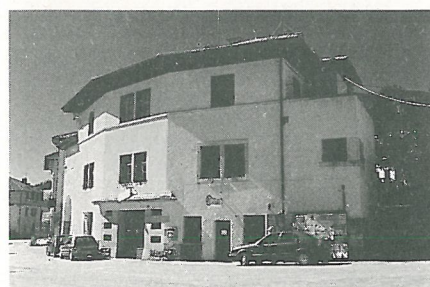
Municipio: iniziati i lavori di ristrutturazione
