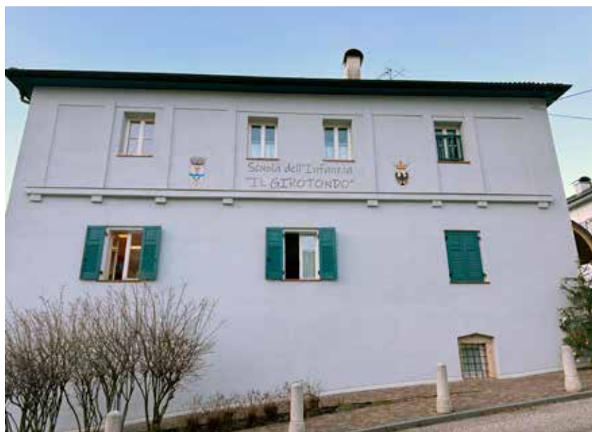
Lavori di efficientamento energetico edificio comunale Asilo Bucaneve a Sant'Orsola.
