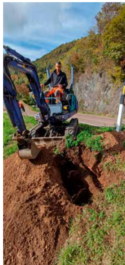
Lavori di verifica tipologia terreni per la realizzazione del nuovo marciapiede di collegamento tra la Frazione di Mala e la località Stefani fondi PNRR Borghi.
