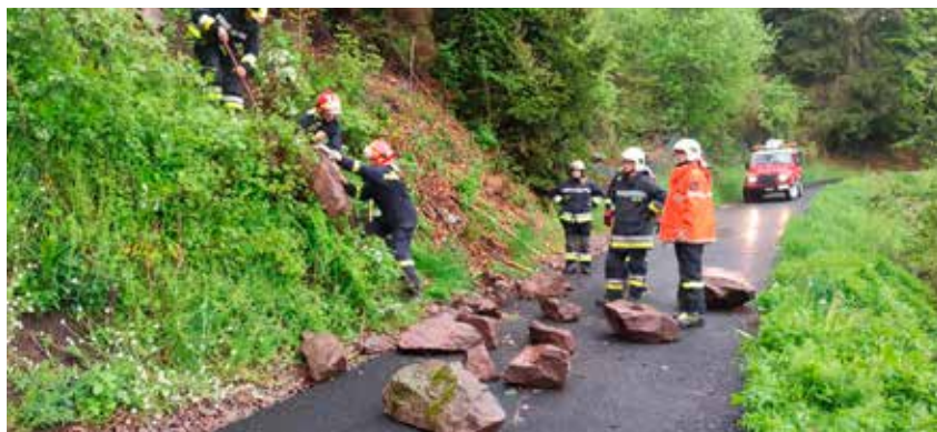
Intervento urgente strada Costarefolo. I Vigili del Fuoco sono stati fondamentali per un primo monitoraggio e messa in sicurezza del versante. Sono seguiti i lavori del ripristino del versante.
