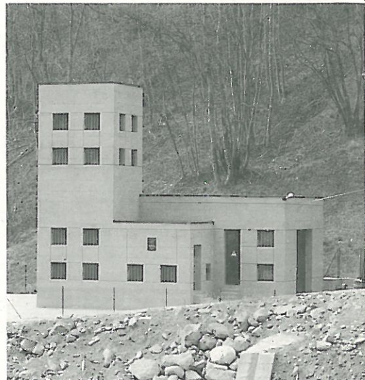
Veduta della centrale idroelettrica di S. Orsola Terme sul Fersina.
