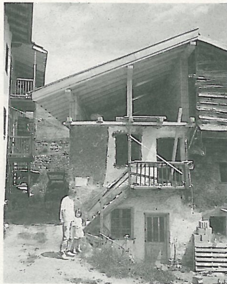
Lavori alla casa sociale in località Borti.
