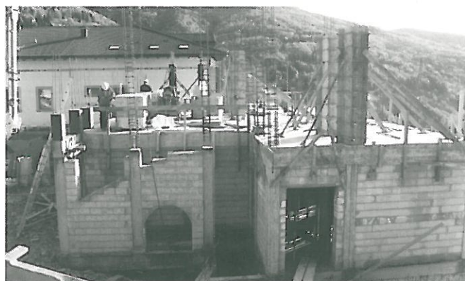
Cantiere nuovo edificio polifunzionale biblioteca e centro della salute
