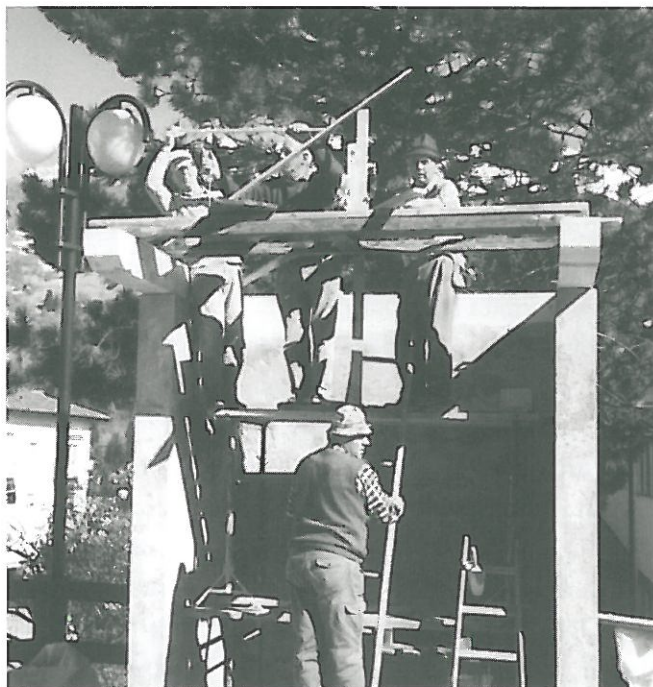
Capitello nuovo in costruzione
