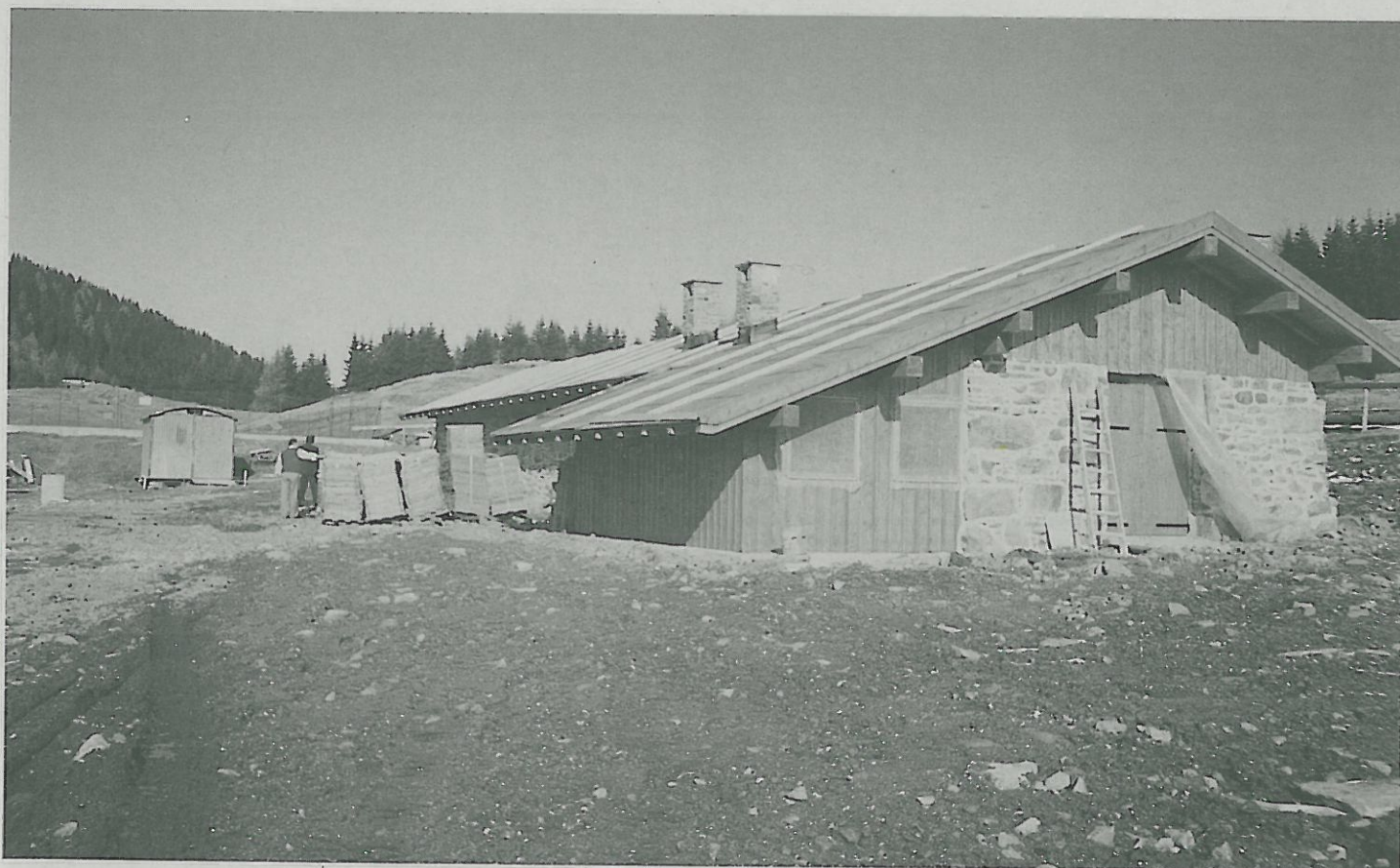
Malga Cambroncoi in corso di ultimazione.
