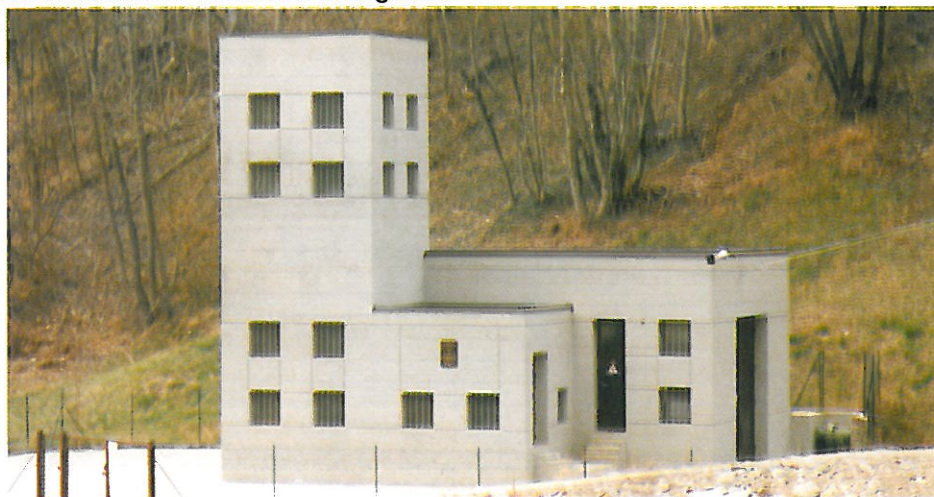
Esterno Centrale Idroelettrica sul Fersina
