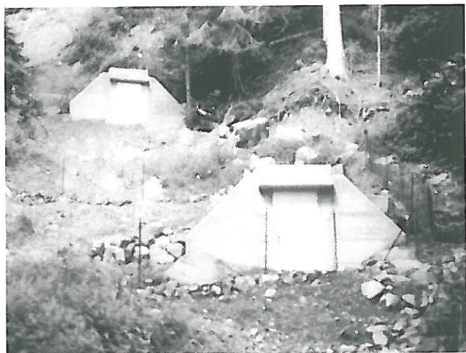
Manufatti della sorgente "Val Granda" S. Orsola Terme dell'acquedotto comunale
