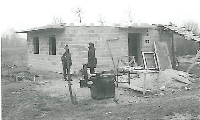
La casa prima dei lavori
