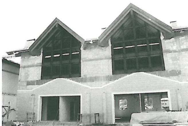
Lavori di rifacimento dell'edificio polifunzionale in località Pintarei
