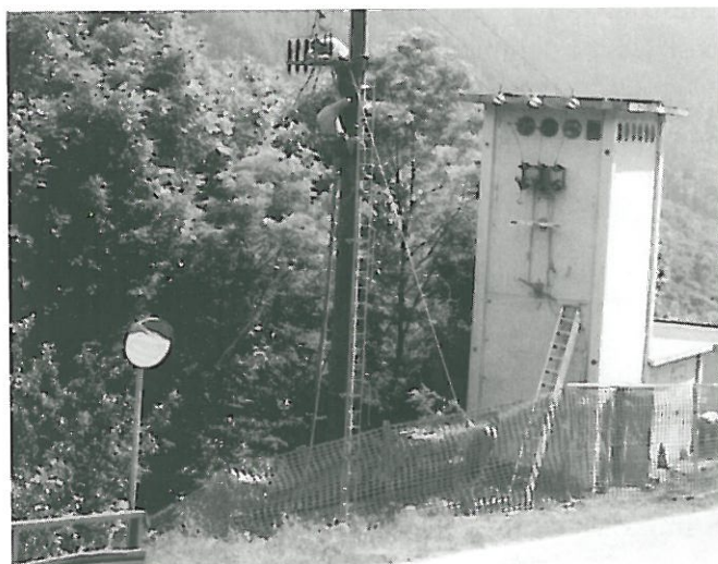
Lavori di rifacimento e potenziamento della cabina elettrica in località Tasini
