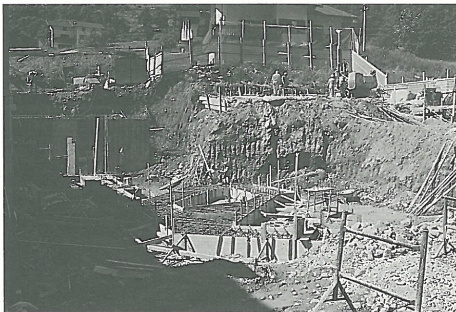
Cantiere lavoro del magazzino pompieri
