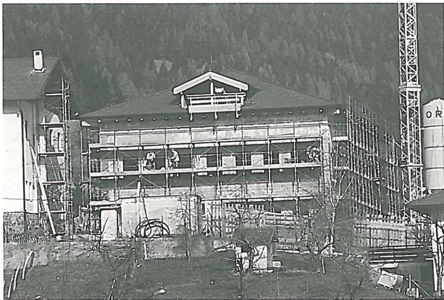
Cantiere lavoro della Scuola Elementare
