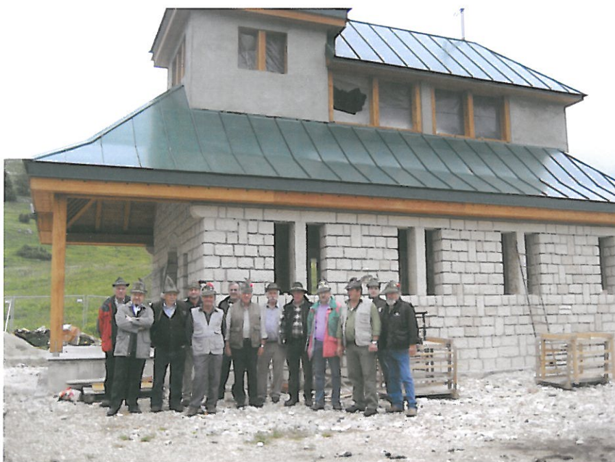
Gli alpini davanti alla chiesetta ristrutturata
